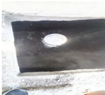
अपारेल एक्सपोर्ट प्रमोशन काउंसिल फरीदाबाद, के आर.डब्ल्यू.एच. प्रणाली में गंदगी एवं जल भराव
